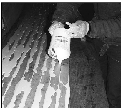
Mellomrommene mellom trestavene fylles med West System epoxy, bruk sprøyte, sparkel eller blandebeget med «tut». West System Norge leverer tompratører med stempel og spiss.
